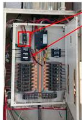
図1.既設分電盤と新規ブレーカ設置
