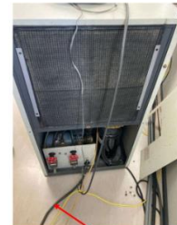
既設電源ケーブル仕様: SQ35-3C (許容電流約25A)
