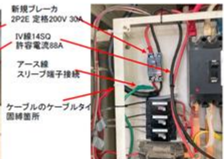
図2.新規ブレーカ設置 拡大写真
