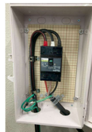
図3.増設したブレーカ(AT:75A)
