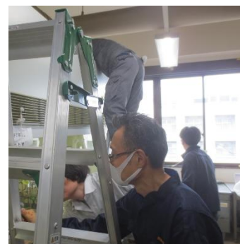
図 1.ドラフト修理の様子
