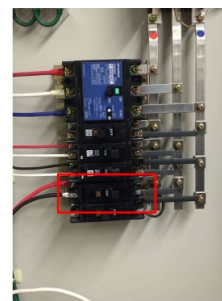
図2.#3112 新設ブレーカ(AT 30A)
