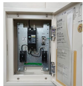
分電盤内に電気炉用に3相専用ブレーカーを設 置。（設置済み未使用ブレーカーの活用も含む）
