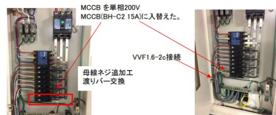
図2.#3503 分電盤(単相側 施工後)
