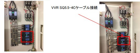
図1.#3503 分電盤(単相側 施工前)
