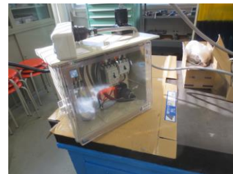
図3. 分電盤の作成
