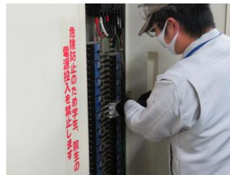
図2. 電気工事作業2
