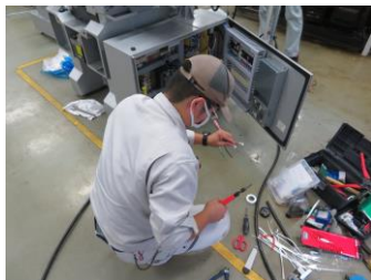
図1. 電気工事作業1
