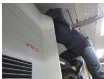
図2. 狭い空間での作業
