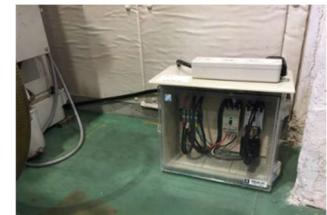
図 3. 新設分電盤
